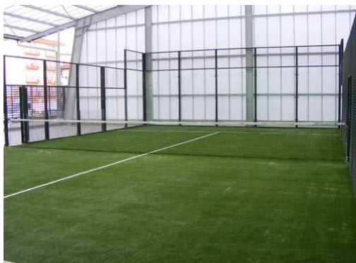
PISTAS DE PADEL DE LOIDIBARREN Su utilización se gestiona desde el Polideportivo Municipal. Cuenta con iluminación artificial, cerramiento acristalado y pavimento de hierba artificial.
